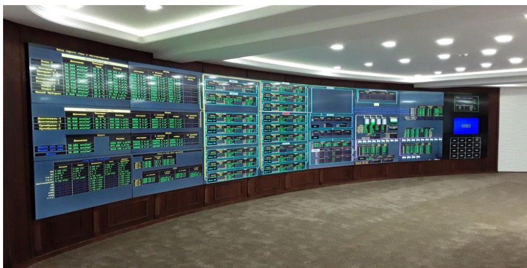
Рис 2. АСОДУ крупного промышленного предприятия созданная на SCADA “Integrator”
